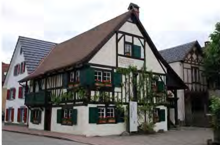
Das Hebelhaus in Hausen i. Wiesental
